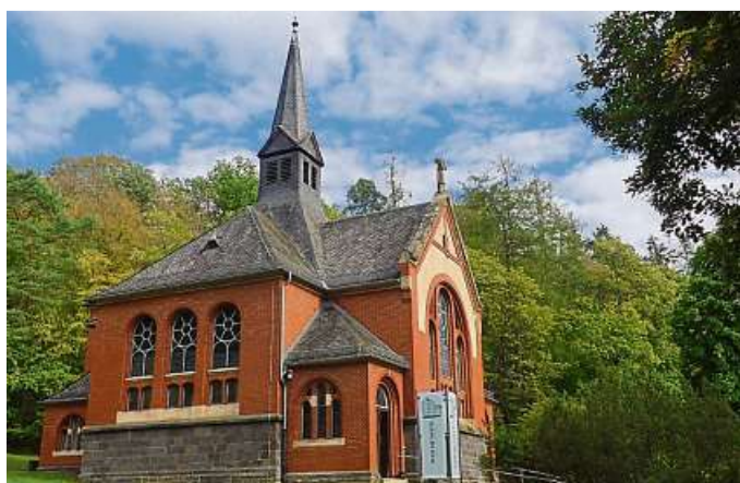
Die historische Klinikkapelle auf dem Gelände von Vitos Weil-Lahn wurde entweiht, denkmalfachgerecht saniert und behutsam in ihre neue Rolle überführt. Als Ausstellungs- und Lernort soll sie künftig über die Vergangenheit informieren.
